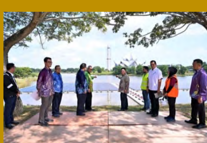
UMPSA miliki panel solar terapung yang terdiri daripada 240 unit panel, 1 unit inverter 125 Amp dan lebih daripada 136 unit pelampung bagi membentuk kawasan seluas 2,574 meter persegi.
